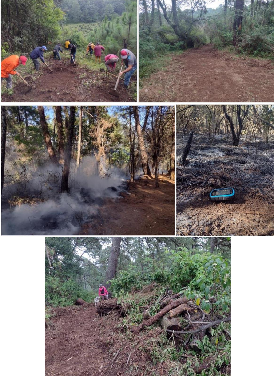
Imagen 59 Apertura de brechas cortafuego y quemas controladas para reducción de material combustible
