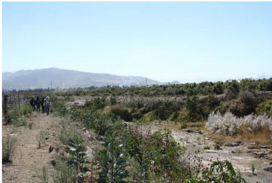
Figura 45. Recorrido por el predio Cisneros, para identificar la ubicación de las obras a ejecutar.
