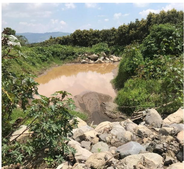
Figura 59. Presa de piedra acomodada, que logró interceptar sedimentos y escurrimientos y por ende bajar la velocidad de los mismos.
