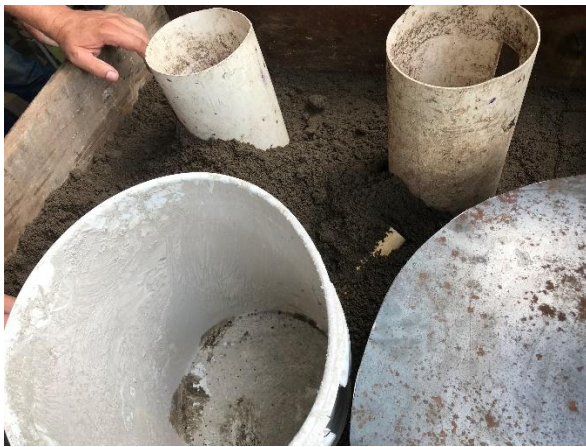
Figura 138. Construcción de las recamaras conductoras de calor de la estufa.
