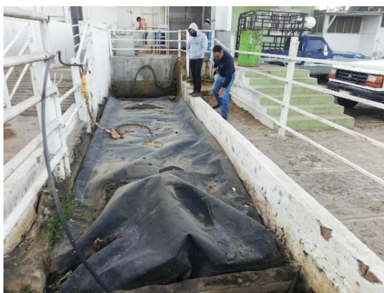
Figura 22. Biodigestor de rastro de Gómez Farías
