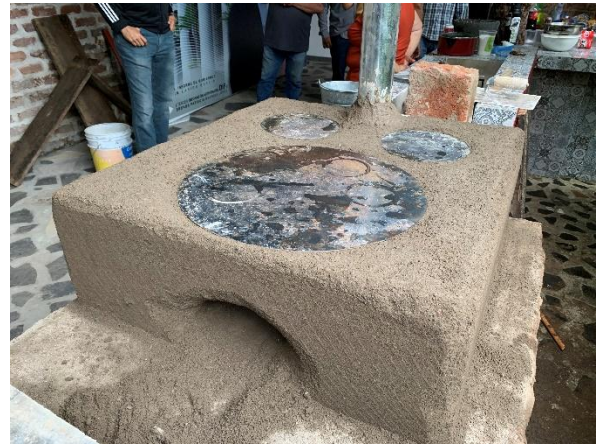
Figura 139. Estufa ahorradora de leña terminada.
