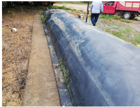
Figura 31. Reactor de 40m 3 activado en rastro de Pihuamo.
