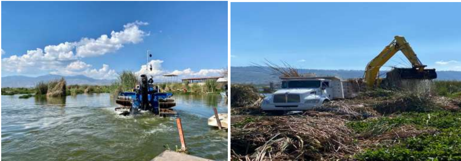
Fig. 2. Labores de acarreo, extracción y transporte de islotes de tule flotante.
