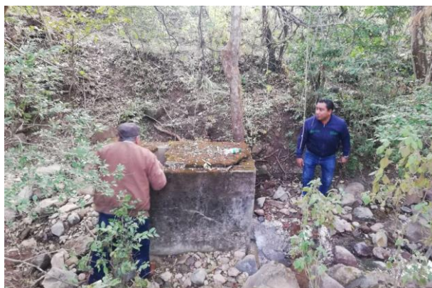
Figura 6. Registro de cemento y tubería de conducción de agua.
