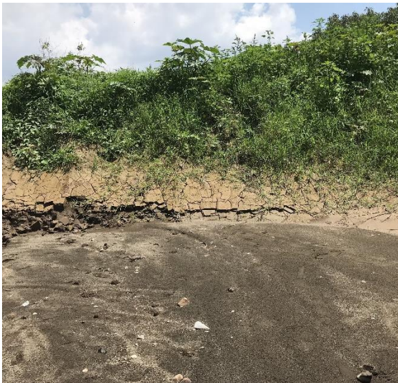
Figura 26. Presa compactada de tierra para controlar la velocidad de los escurrimientos.
