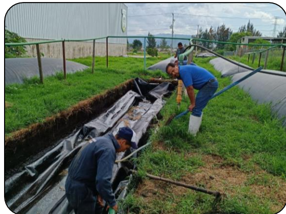
Figura 22. Reparación de fugas en reactor de 40m 3 , rastro de Zapotlán el Grande.
