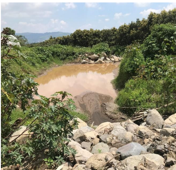
Figura 28. Presa de piedra acomodada, que logró interceptar sedimentos y escurrimientos y por ende bajar la velocidad de los mismos.
