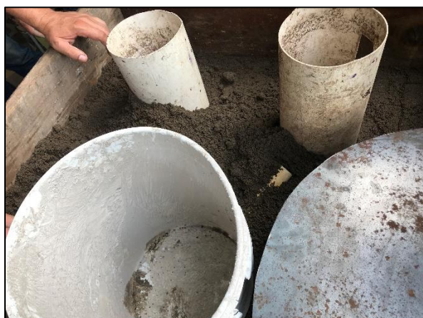
Figura 45. Construcción de las recamaras conductoras de calor de la estufa.
