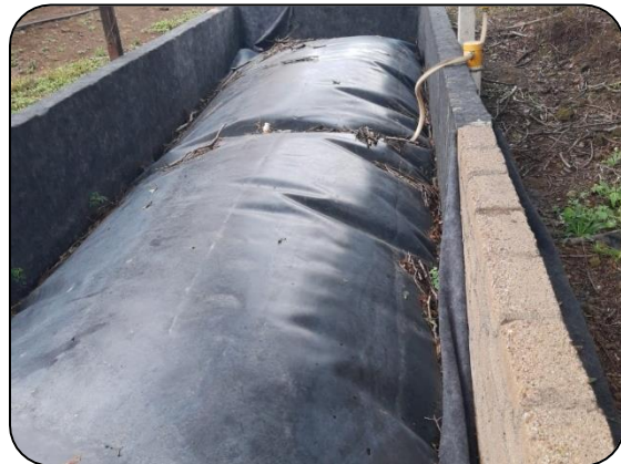
Figura 20. Biodigestor de 20m 3 rastro de Tuxpan activado.
