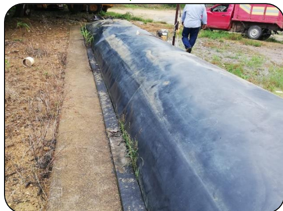
Figura 24. Reactor de 40m 3 activado en rastro de Pihuamo.
