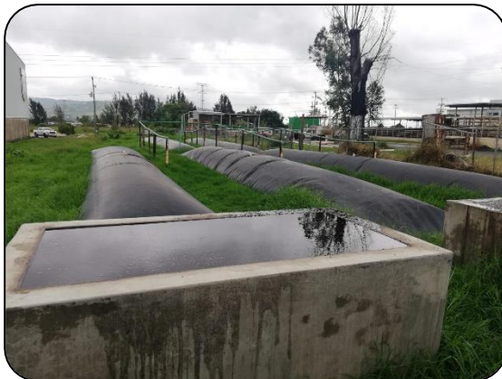
Figura 21. Tinas de influente sobrellenadas, rastro de Zapotlán el Grande.
