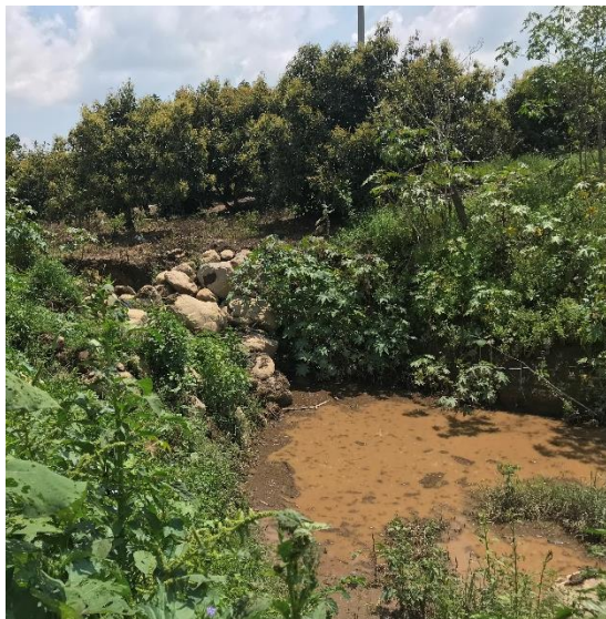
Figura 27. Presa de tierra y piedra acomodada, para controlar el exceso de escurrimientos, que logró interceptar sedimentos.
