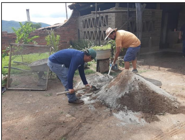
Figura 43. Mezcla de los materiales necesarios para construir la estufa.
