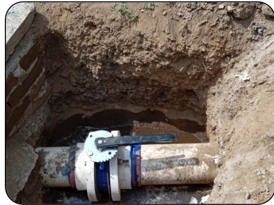
Figura 3 Válvula de influente en el rastro de Tuxpan
