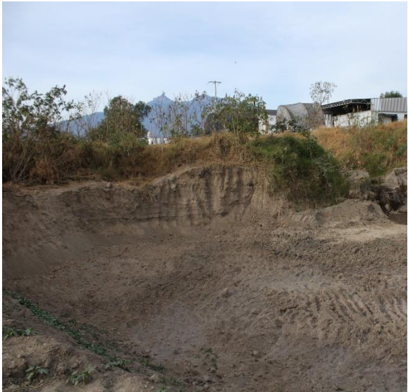
Figura 4. Primera estructura para la retención de azolves.
